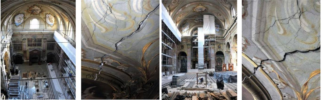
L'intervento di consolidamento di alcune delle strutture della Chiesa di Sant' Agata del Carmine a Bergamo, che rientra in un più ampio progetto di restauro del complesso dell'intera fabbrica, rappresenta un esempio particolarmente significativo per la trattazione delle problematiche che interessano il campo degli ancoraggi iniettati nelle murature storiche.
