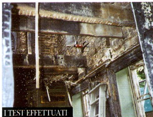
*Test di resistenza al fuoco.* I test condotti presso il Building Research Establishment, (BRE) in Gran Bretagna, hanno mostrato che le ancore Cintec, sottoposte ad una temperatura di 1200°C, hanno garantito un normale funzionamento per 2 ore.
