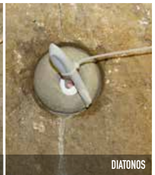
DIATONOS (with pre-tensioning and countersinking con svaso e pre-sollecitazione)
