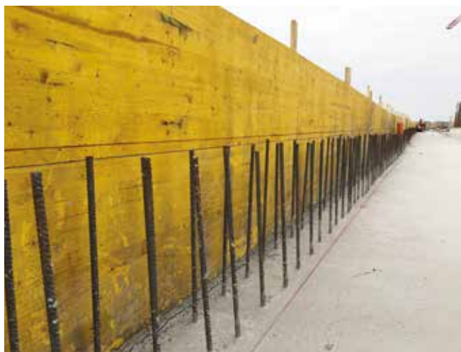
Inghisaggi di barre ad aderenza migliorata
