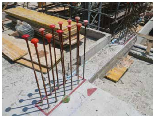
Armature post installate di un nuovo pilastro
