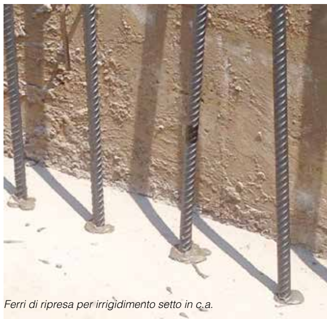
Armature post installate di un nuovo pilastro
