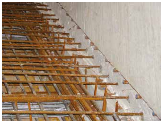
Armature post installate per un nuovo solaio
